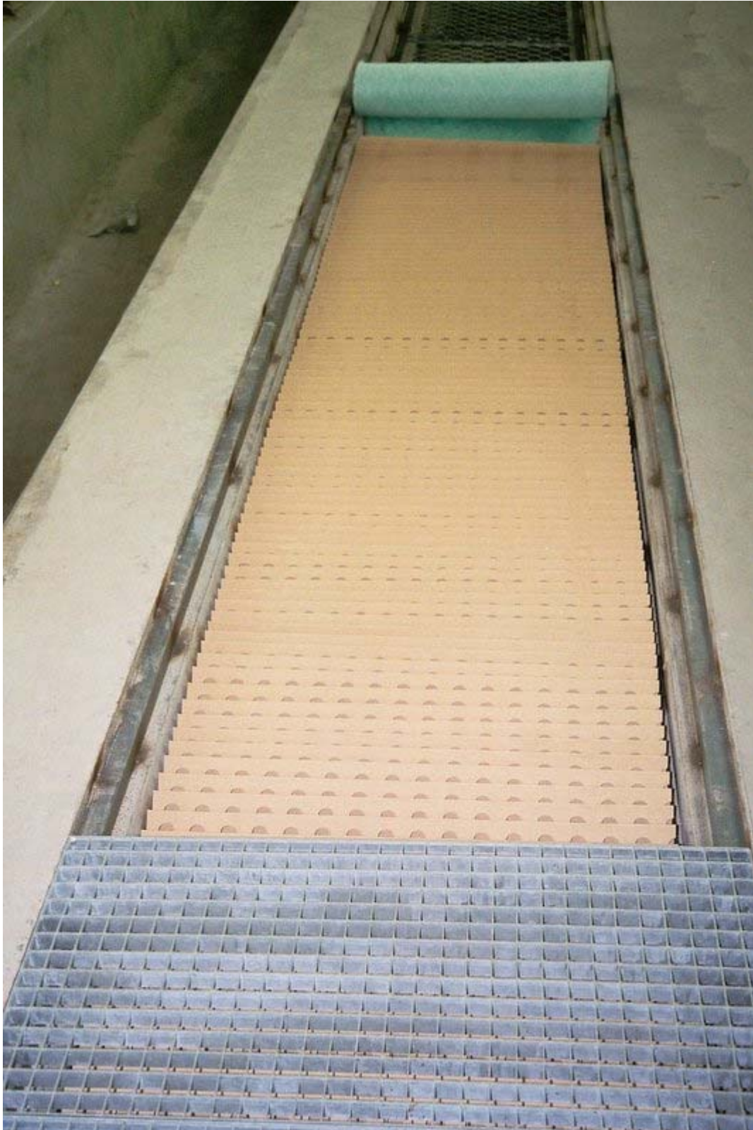
Bodenabsaugung mit Gitterrost
