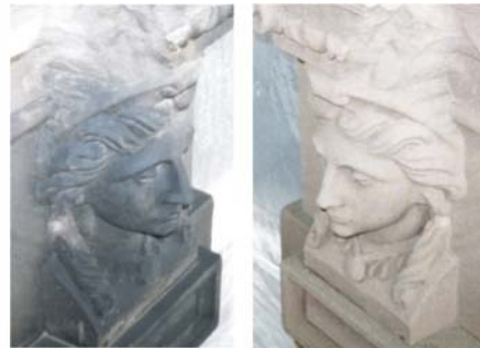
Naturstein - Büste vor und nach der Reinigung mit der SAPI Mini-Wirbelstrahltechnik
