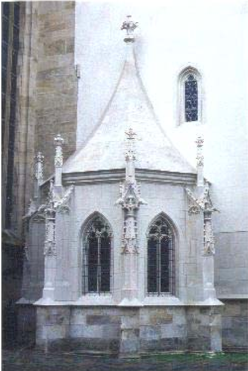
F 2 Dom Eichstätt / Chor der Kapitelsakristei Ergebnis nach der Reinigung mit dem "Vario"-Wirbelstrahlverfahren . Im unteren Wandbereich ist die Restaurierung noch nicht abgeschlossen.
